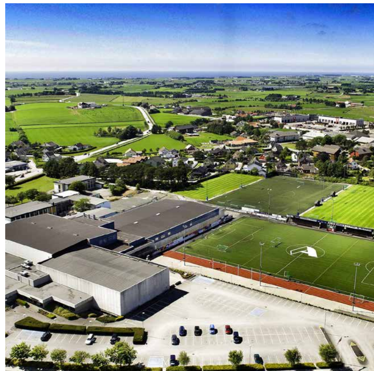
Nye Loen idrettsanlegg
